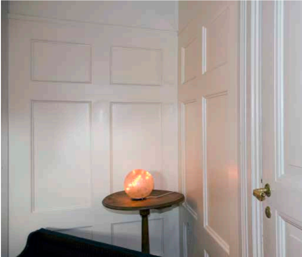
ÄLDRE VÄGGPANEL I HUVUDBYGGNADENS HALL. FOTO: J. MALMBERG
